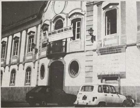
Continuam a bom ritmo as obras de restauro do Palácio Barahona, onde futuramente vai ser instalado o Arquivo Distrital de Portalegre.
